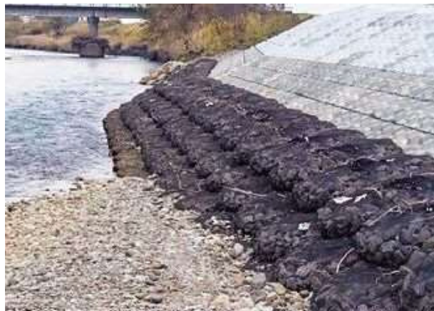
護岸の根固め工・洗掘防止
