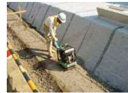
基礎材の設置
