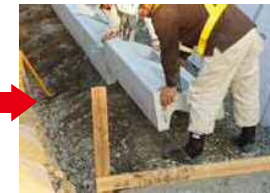
ブロックの据付
