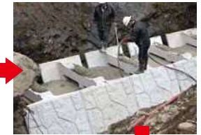
胴込コン・裏込材投入
