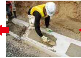
コンクリート表面仕上げ
