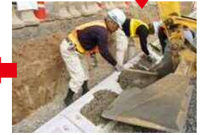
コンクリート投入
