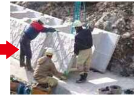
ブロック敷設
