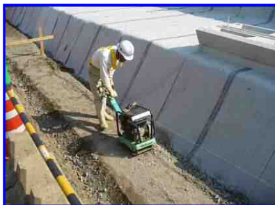
①ブロックを据付するため、基礎材を投入し締固めます。
