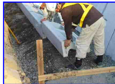
②吊り金具を用いてブロックを重機にて吊り上げ据付けます。
