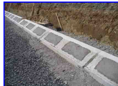
⑥施工完了。
