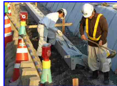
③必要に応じてブロック背面を連結プレートにて連結します。
