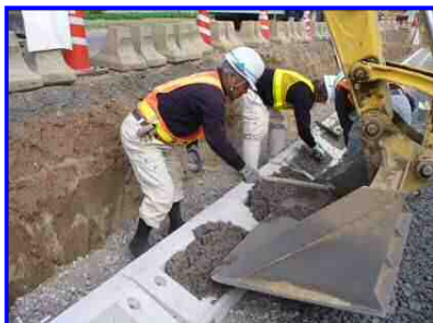
④ベース中詰部にコンクリートを打設、締固めを行います。
