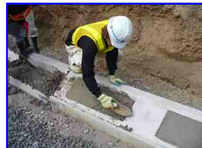
⑤コンクリート打設面にコテをかけ仕上げます。
