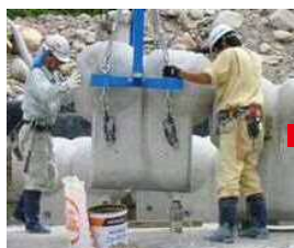
ブロック据付
