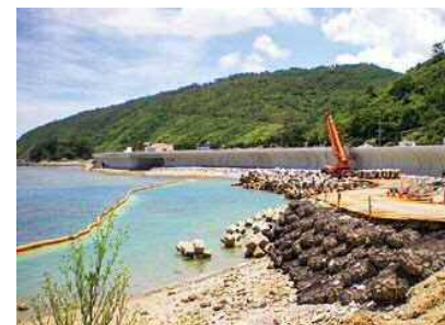
仮設道路の基盤工
