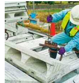
吊り金具取り付け
