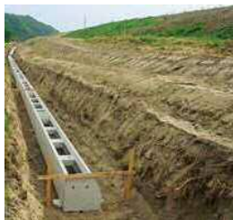
■ベースブロック据付後
