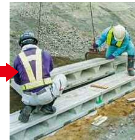
ブロック据え付け
