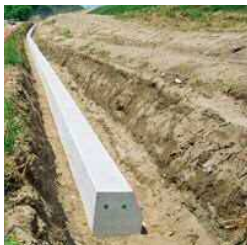
■ベースブロック中詰コンクリート打設後
