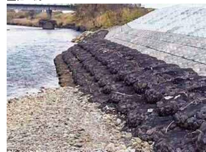
護岸の根固め工・洗掘防止
