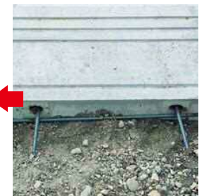
連結鉄筋設置
