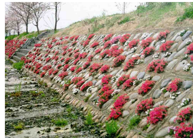
木曾（植栽型）／新堀川（岐阜県）
