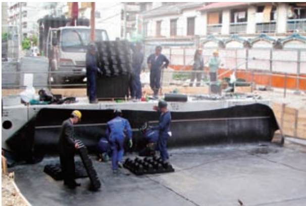
貯留容量:2578m 3 (一次貯留槽:154m 3 、二次貯留槽:2424m 3 )
