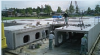
(プレキャスト部材据付工/組立工)
