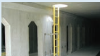
(梯子取付/スクリーン取付/水中ポンプ設置)
