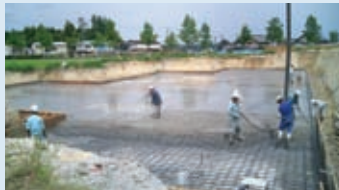
(鉄筋工/コンクリート工)
