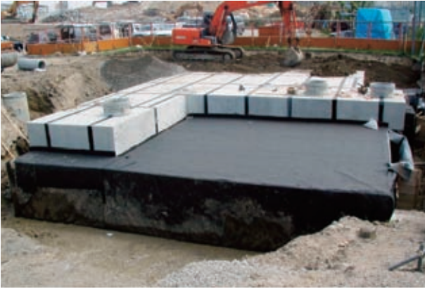
貯留容量:200m 3 (一次貯留槽:115m 3 、二次貯留槽:85m 3 )
