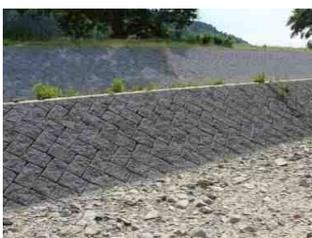
(1) 護岸を分節し、護岸法面の存在感を緩和している。
