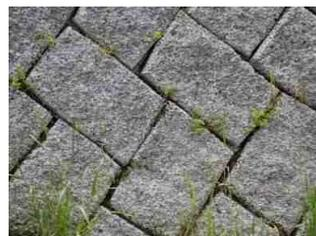
(9) ブロックの深目地部（空隙部）から植生が繁茂している。
