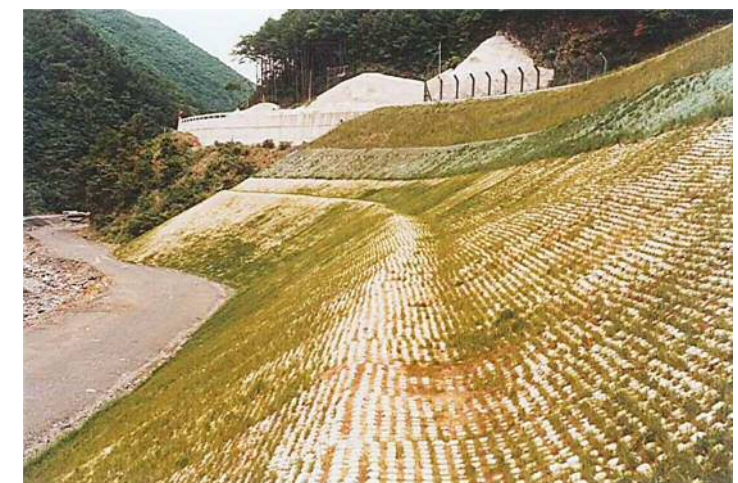
土捨て場（法面保護）
