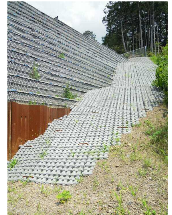
砂防堰堤（袖部法面保護）
