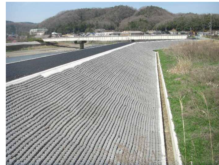
越流堤（裏法面保護）
